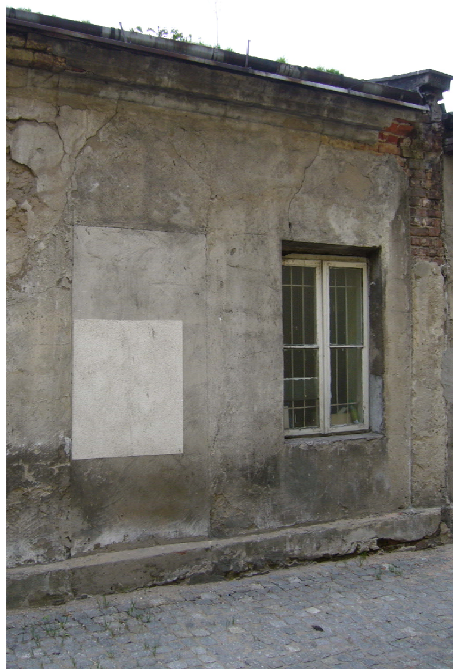
ELEWACJA WSCHODNIA PUNKT FOTO 04 WIDOCZNE ZAMUROWANE DRZWI
